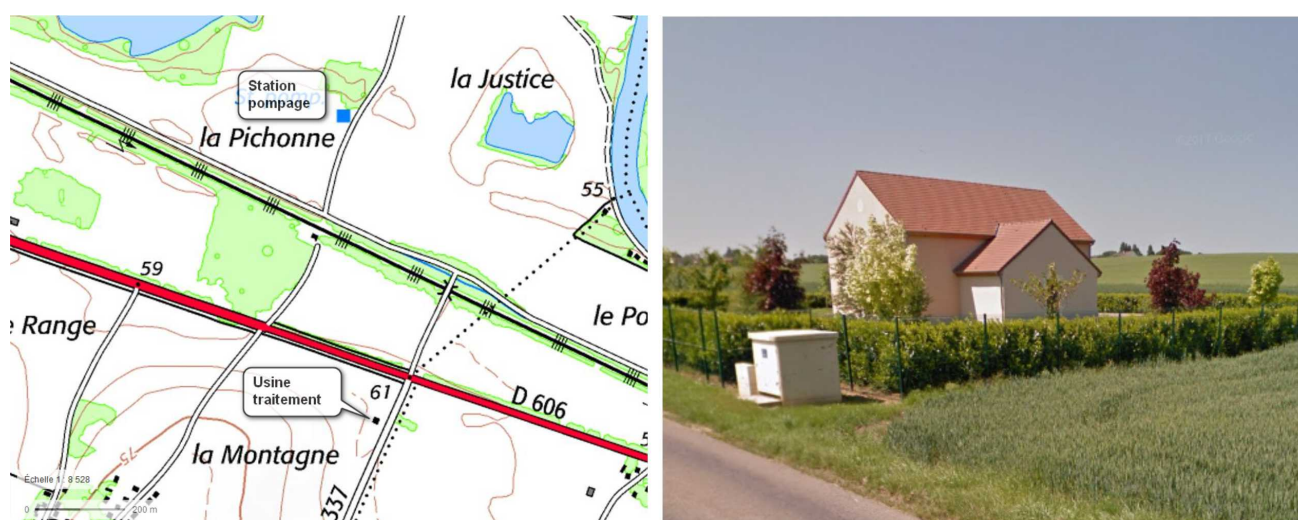
Figure 12 : localisation de l'usine de traitement – cliché de l'usine.
